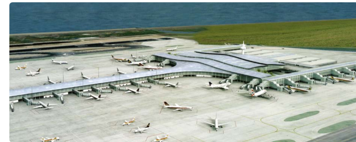
Nueva Terminal T1 para Aena. Aeropuerto del Prat, Barcelona.
