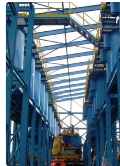
Planta concentradora de cobre y polimetálico para Mina de Aguas Teñidas. Almonaster la Real, Huelva.
