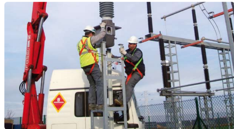
Reforma de la subestación de transformación de 220 kV, en Juneda, Lleida.
