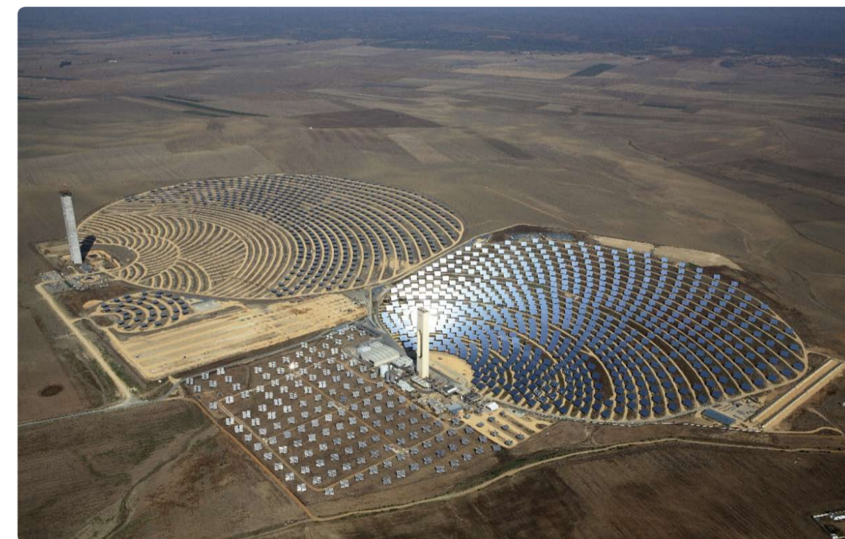
Planta Termosolar para Abener. Sanlúcar La Mayor, Sevilla.
