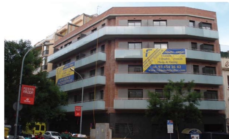
Fachada del edificio de la c. Sant Fructuós, Barcelona.
