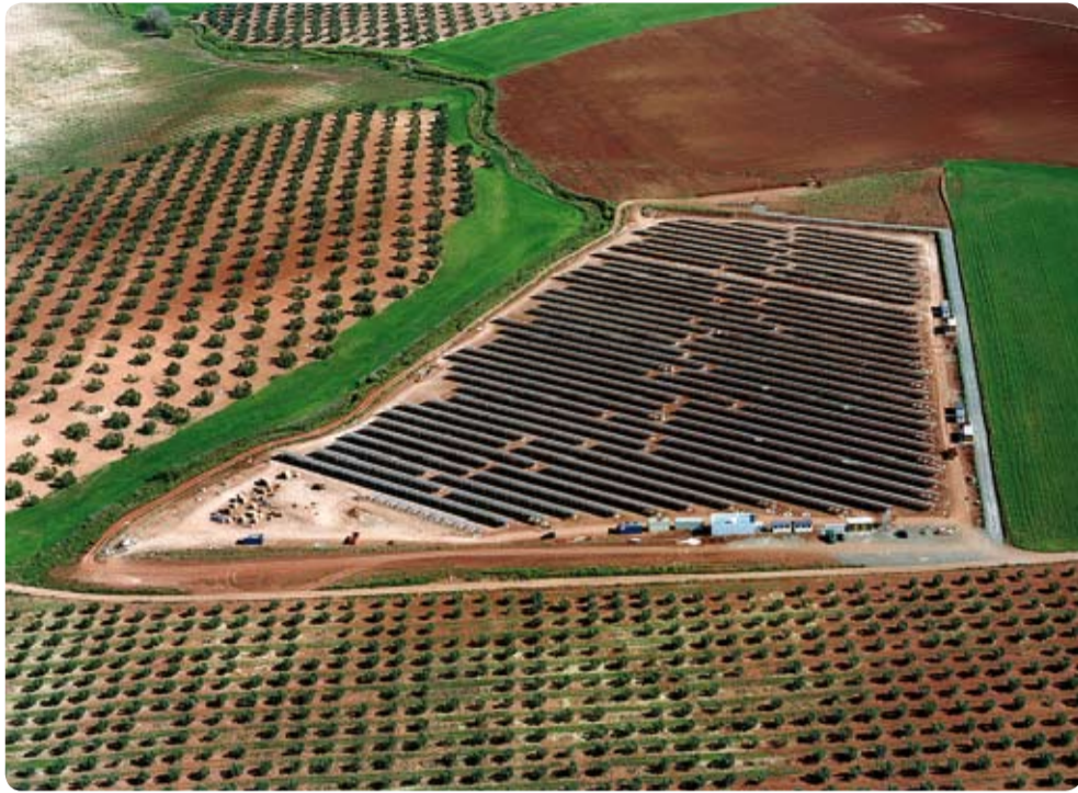
Huerto solar Sol de Málaga.
