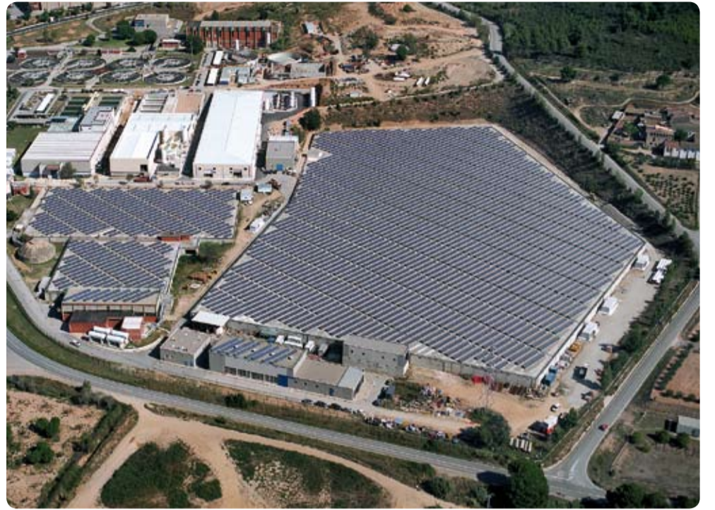
Aguas Ter Llobregat. Planta de Abbrera, Barcelona.
